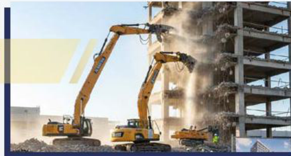
أعمال الهدم والحفر والردم
